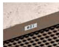
Numéro perforé sur plaque en acier
